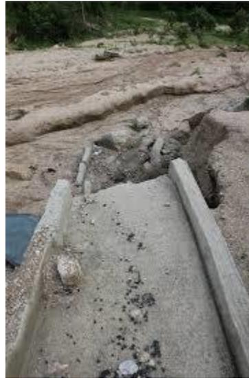
**Bordillos:** Los bordillos son elementos que que interceptan y conducen el agua que por el efecto del bombeo corre sobre la corona del camino, descargándola en los lavaderos para evitar erosión a los taludes de los terraplenes que estén conformados por material erosionable. Los bordillos pueden ser de concreto hidráulico, concreto asfáltico o suelo-cemento.
