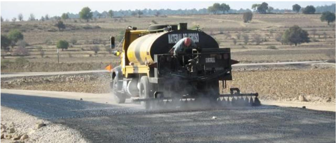
(Fotografía No. 3 Aplicación de riego de liga )
