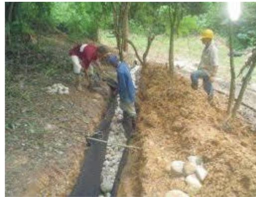
**Lavaderos:** Los lavaderos son canales que conducen y descargan el agua recolectada por los bordillos, cunetas y guarniciones a lugares a donde no cause daños a la estructura del pavimento. Los lavaderos pueden ser de mampostería, concreto hidráulico o metálicos. Si se construyen con mampostería o concreto hidráulico, generalmente tienen sección triangular con el propósito de lograr una depresión en su intersección con el acotamiento, para facilitar la entrada de agua al lavadero.
