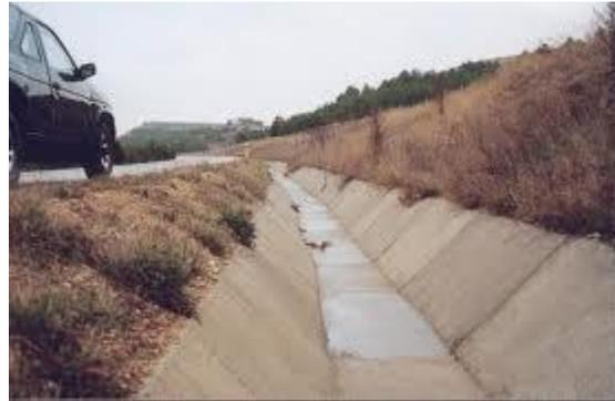
**Contracunetas:** Las contracunetas son zanjas o bordos que se construyen en las laderas localizadas aguas arriba de los taludes de los cortes, con el objeto de interceptar el agua que escurre sobre la superficie del terreno natural conduciéndola a una cañada inmediata o a una parte baja del terreno, para evitar el saturamiento hidráulico de la cuneta y el deslave y/o erosión del corte. Las zanjas pueden estar recubiertas o no y los bordos pueden ser de tierra, concreto o suelo cemento.
