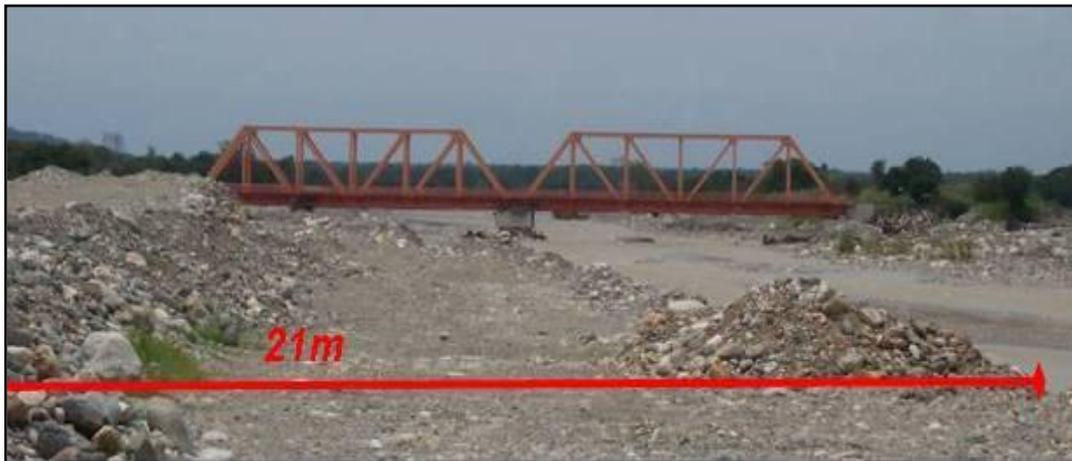
**Fotografía 2.31.- Vista panorámica del Río Pijijiapan después de las inundaciones, fotografía tomada 19 de Junio del 2006, muestra el estado actual, el Dique mide de 21 m de ancho.**
