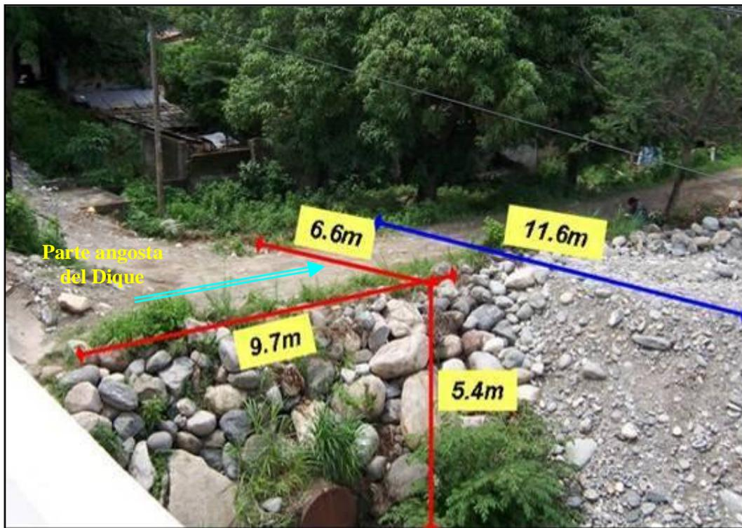
***Fotografía 2.29.- Porción más angosta del dique con 6.6 m de ancho y 5.4 m de alto, se ubica en el Barrio El Arenal, Pijijiapan.***
