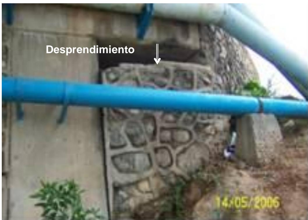
*Fotografías 2.24 y 2.25.- Cimientos y base del Puente Pijijiapan en su margen derecha afectados por fracturamiento, corrosión, asolvamiento, deslizamiento y desprendimiento de materiales.*
