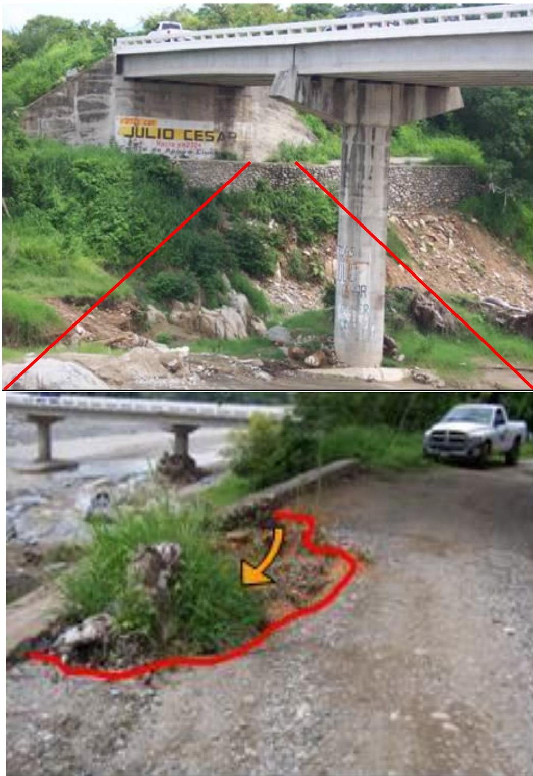
**Fotografías 2.27 y 2.28.- Base del Puente Pijijiapan afectada en su extremo poniente por deslizamiento y colapso de materiales.**
