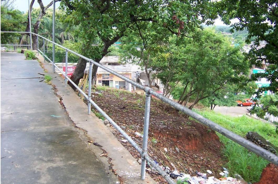
**Fotografía 2.13.-** Tomada en el mirador de la antigua estación de autobuses O.C.C. donde se observa fracturamiento en el concreto, el cual se encuentra en la parte superior del corte mostrado la corona de deslizamiento de la fotografía 2.14.
