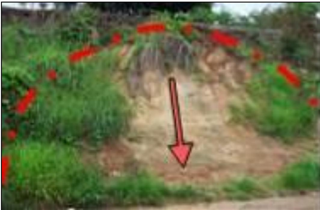
*Fotografía 2.11.- Rumbo del deslizamiento con un ángulo de corte de 53°, el rumbo de movimiento hacia el SW 30, del corte en la 4ª avenida norte poniente esquina con la calle central norte del Barrio el Cerrito.*
