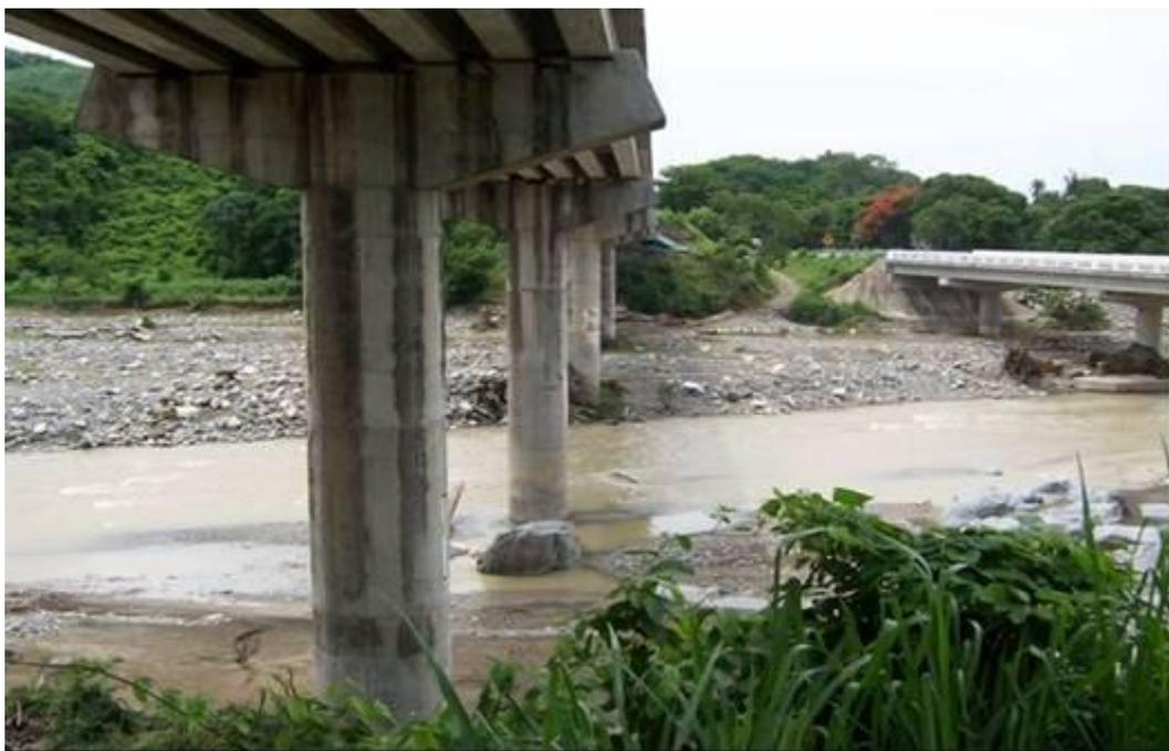
***Fotografía 2.26.- Cimientos y base del Puente Pijijiapan en ambas márgenes afectadas por fracturamiento, corrosión, asolvamiento, deslizamiento y desprendimiento de materiales.***
