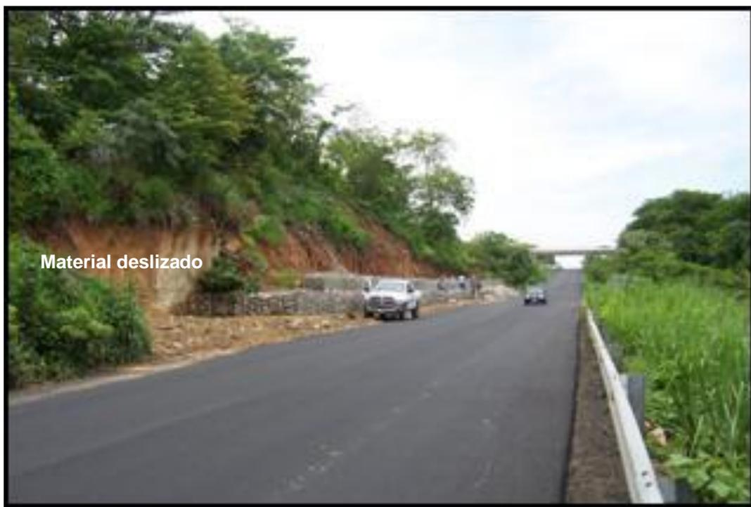
*Fotografías 2.14 .- Carretera Federal No 200, tramo Pijjiapan-Tonalá, altura del lugar conocido como los “Tanques”, muestra la zona de deslizamiento y la fila de gaviones que tratan de detener la inestabilidad del terreno*
