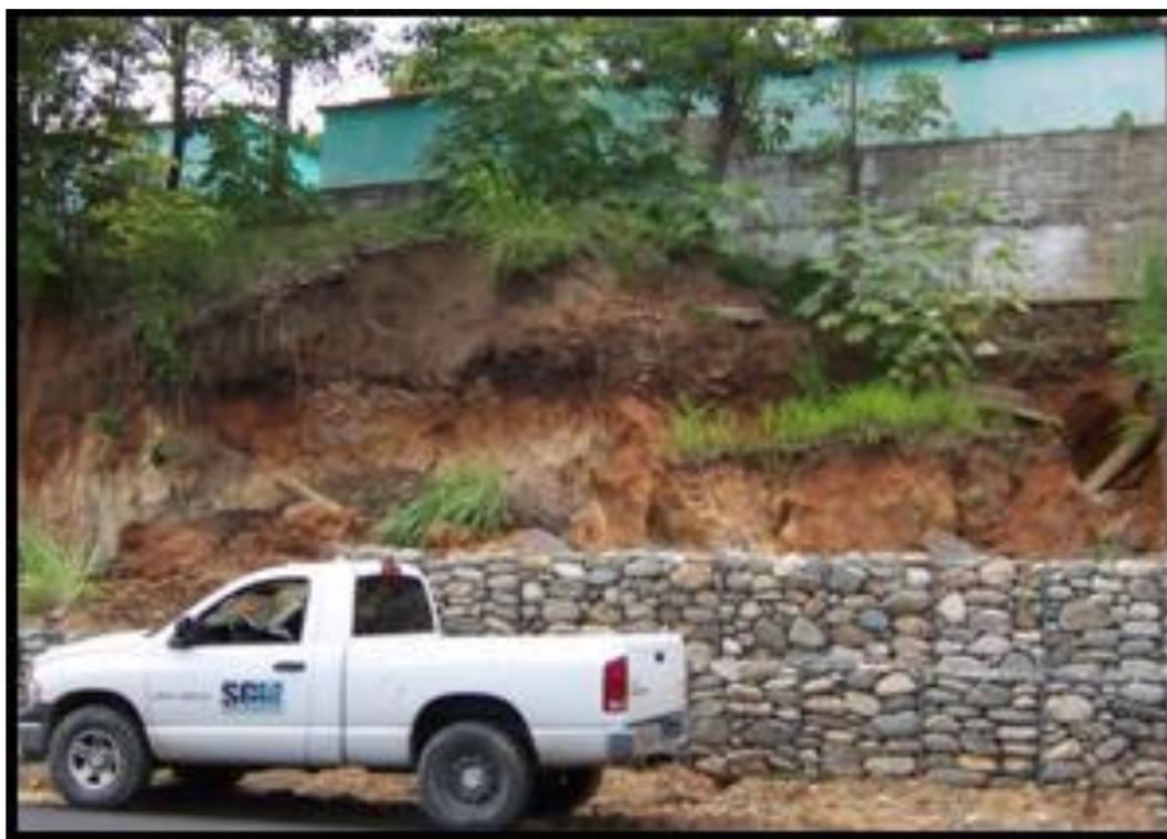
*Fotografía 2.15.-Tanques de agua potable que abastece a la ciudad. Los “gaviones” que colocaron no cubren todo el corte, por lo se encuentra en alto peligro, ya que el material continua deslizándose sobre los gaviones.*
