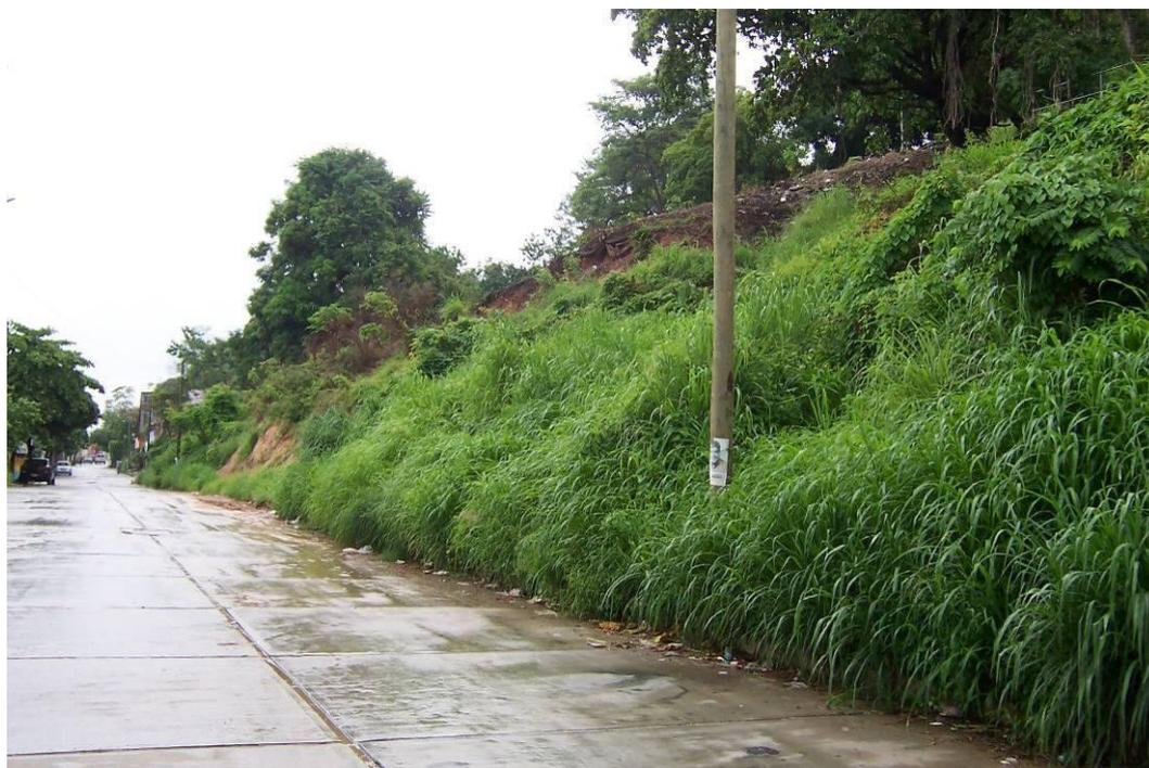
*Fotografía 2.12.- En esta panorámica se observa el corte de 100 m de largo por 5 m de alto que corresponde a la corona del deslizamiento.*
