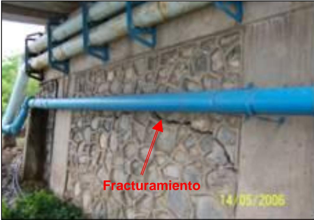
*Fotografías 2.23.- Base del Puente Pijijiapan afectados por fracturamiento, corrosión y asolvamiento.*
