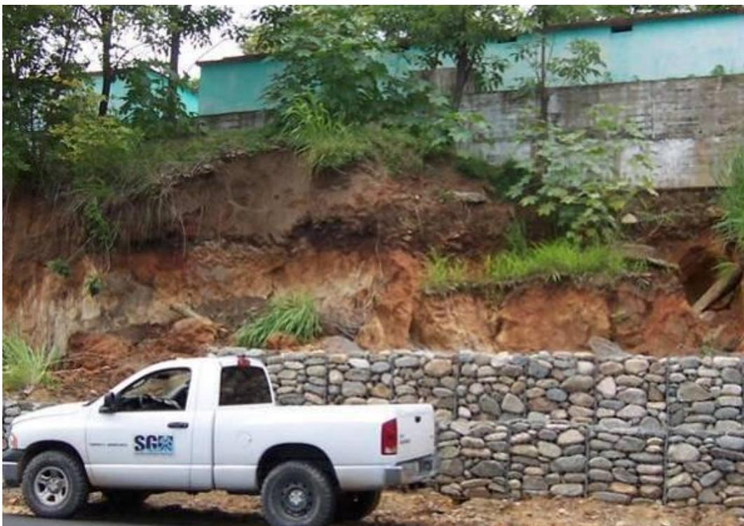
**2.5.-** *Los Depósitos de agua potable que abastecen la ciudad de Pijijiapan están en peligro de derrumbarse debido a que se instalaron en zonas de inestabilidad.*
