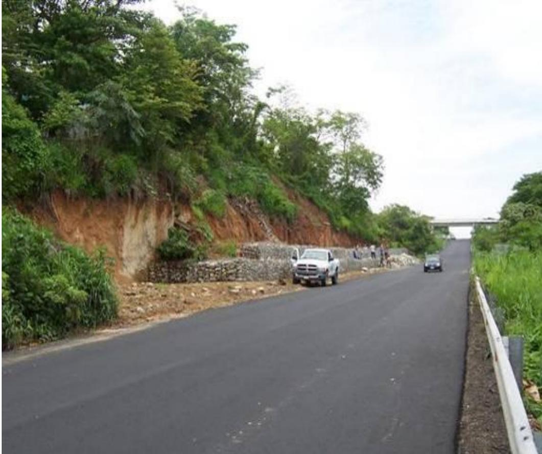
**2.4.-** *Sobre la traza de la falla Motagua se genera un deslizamiento y la fila de gaviones fue realizada para estabilizar el talud y tratar de detener la caída de materiales.*
